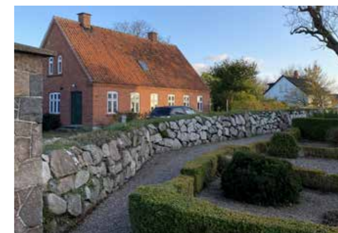
8. Mod øst er flere gravsteder tomme og udlagt i grus. Grus spænder helt ud til diget og der savnes en rumskabende beplantning mod bebyggelsen på den andenside af kirkegården.
